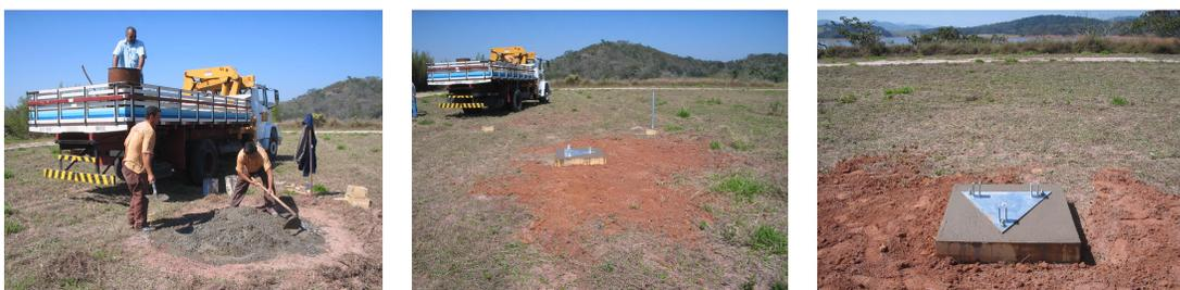
Figura 2.5.1 – Obras civis para instalação das estações meteorológicas.
