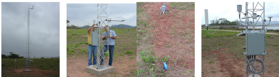
Figura 2.5.2 – Instalação dos sensores, torre com anemômetro e sensores do solo em Paraibuna.
